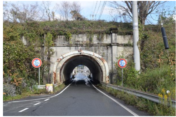
写真：天井川（百瀬川）の下を通る道路 岩崎撮影（2018年12月15日）
